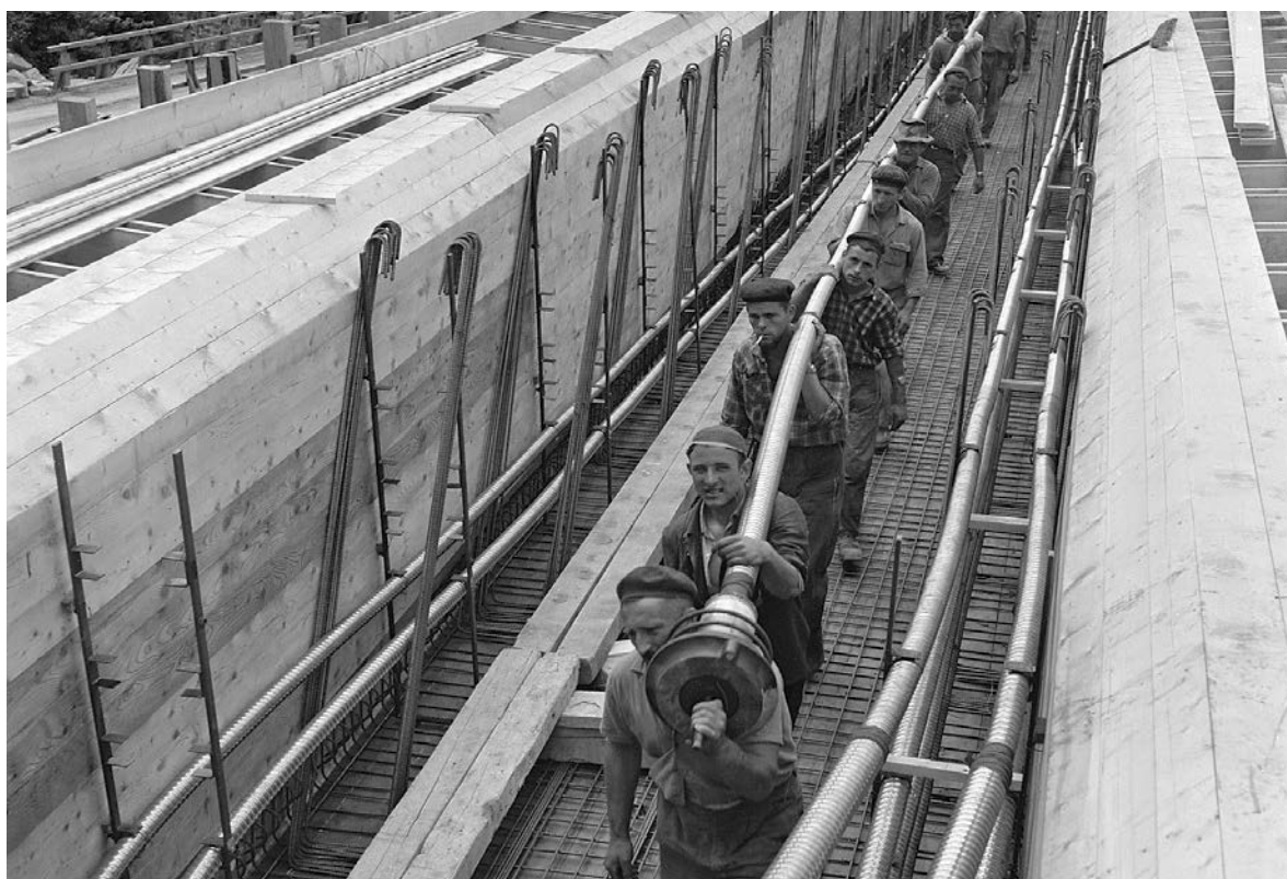
Posa dei cavi di precompressione, Olivone 1960
