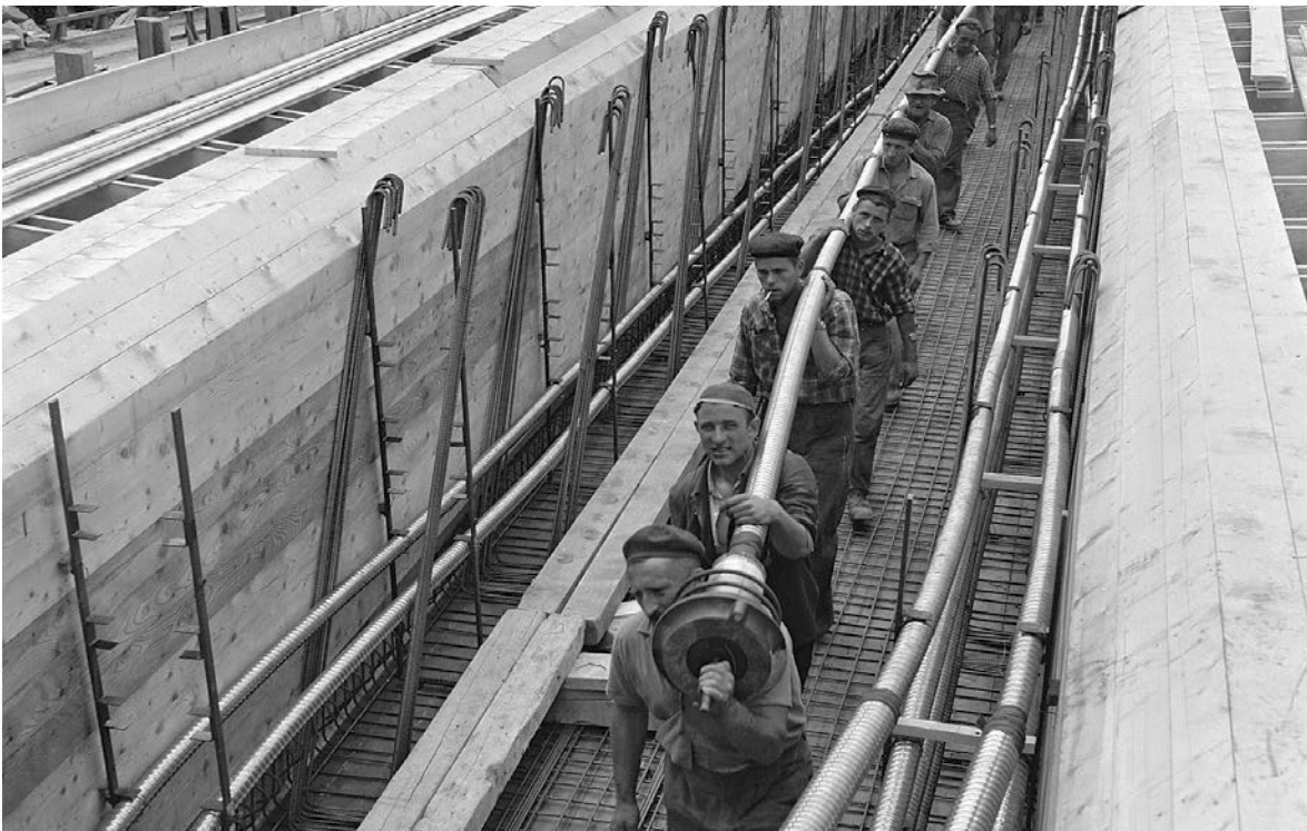
Verlegung der Vorspannkabel, Olivone 1960
